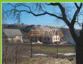
Výstavba nových RD.
