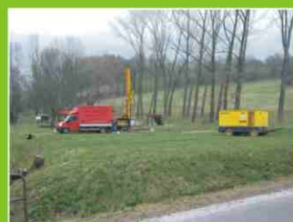
Přípravné práce na vrtech pro posílení vodních zdrojů vodovodu Lánov.
