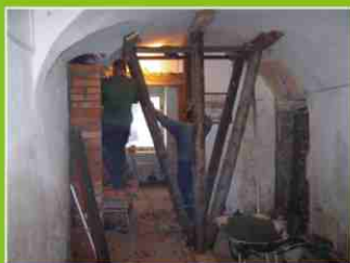
Rekonstrukce bytu čp. 63.
