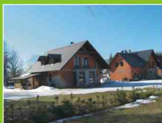
Výstavba nových RD.
