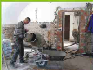
Práce na omítkách.
