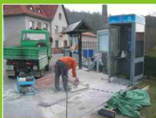
Informační deska OÚ a práce na zpevnění ploch.
