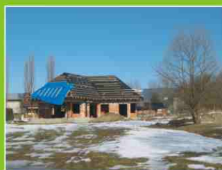
Výstavba nových RD.
