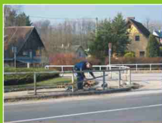
Oprava zábradlí na křižovatce.
