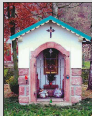
Kaple sv. Huberta po přestavbě.
