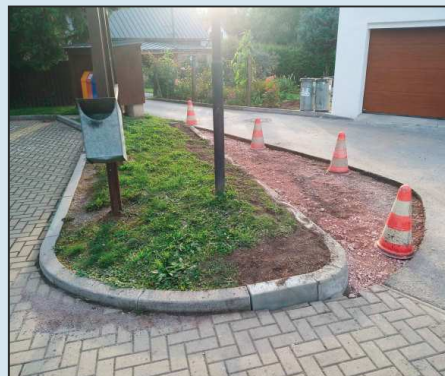
Rozšíření vozovky u IC.
