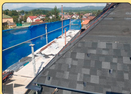
Oprava střechy bývalé fary - areál ZŠ.
