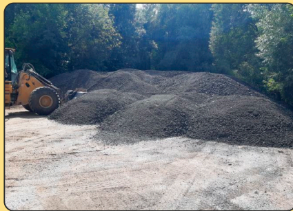
Zajištění asfaltového recyklátu z rekonstrukce silnice Vrchlabí-Lánov, potřebného na opravy místních komunikací.
