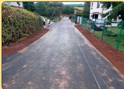
Vyasfaltování cest v lokalitě Seidlov.
