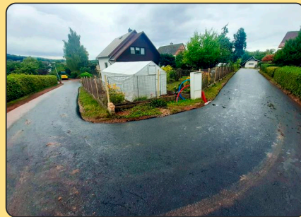
Vyasfaltování cest v lokalitě Seidlov.
