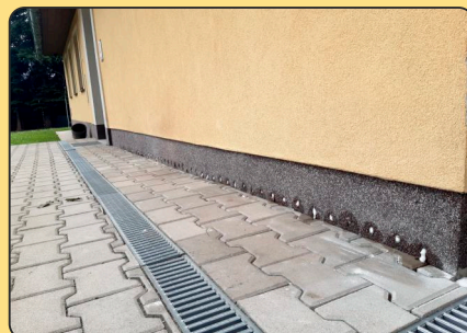
Provedená izolace zdi proti vlhkosti u hasičského domečku v Horním Lánově čp. 75.
