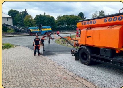
Oprava asfaltu postřikem - cesta za Harmonií.
