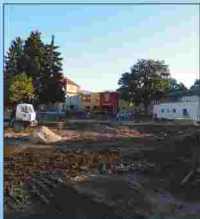
Místo kde vzniká nová školní jídelna.
