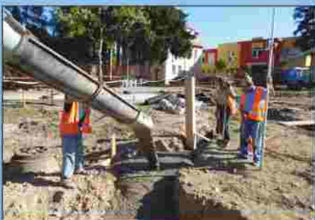
Lítí betonu do základů budoucí ŠJ.
