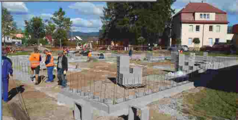
Výzdívání na základech nové ŠJ.
