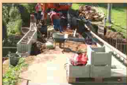
Dolní Lánov - oprava mostu pod kostelem.
