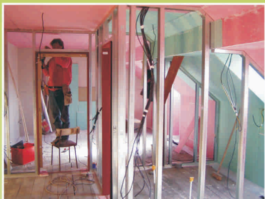
Realizace nájemného bydlení.
