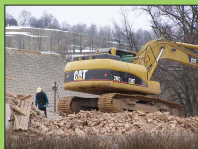
Demolice objektu čp. 38.
