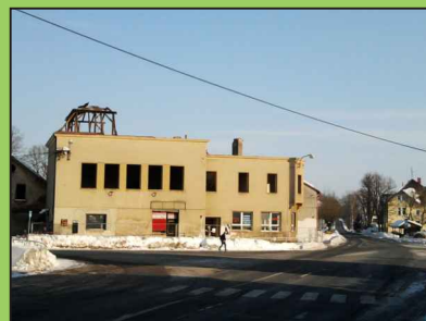
Demolice objektu čp. 38.
