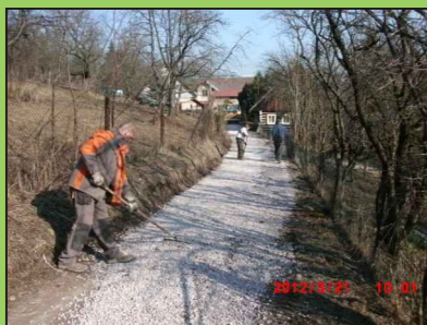
Oprava cest po zimě.
