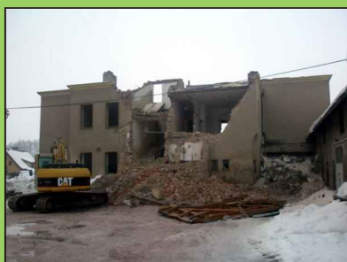
Demolice objektu čp. 38.
