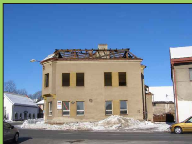
Demolice objektu čp. 38.
