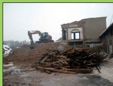
Demolice objektu čp. 38.
