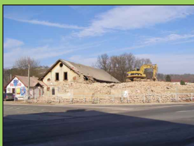
Demolice objektu čp. 38.
