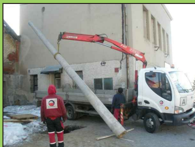
Převážení vrchního vedení NN.
