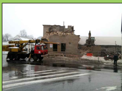
Demolice objektu čp. 38.
