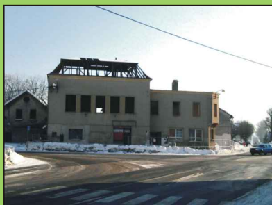
Demolice objektu čp. 38.
