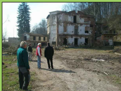
Z předání staveniště demolice pro ČOV Lánov.
