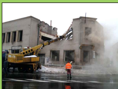
Demolice objektu čp. 38.
