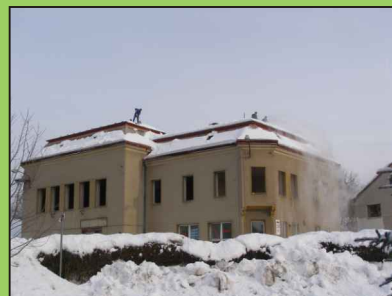
Demolice objektu čp. 38.
