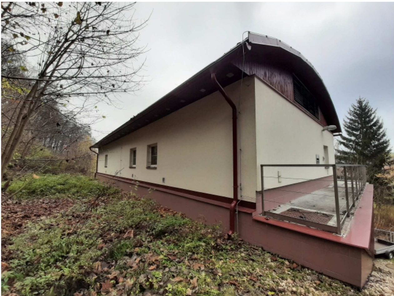
19. Budova ČOV – provozní objekt - zadní strana
