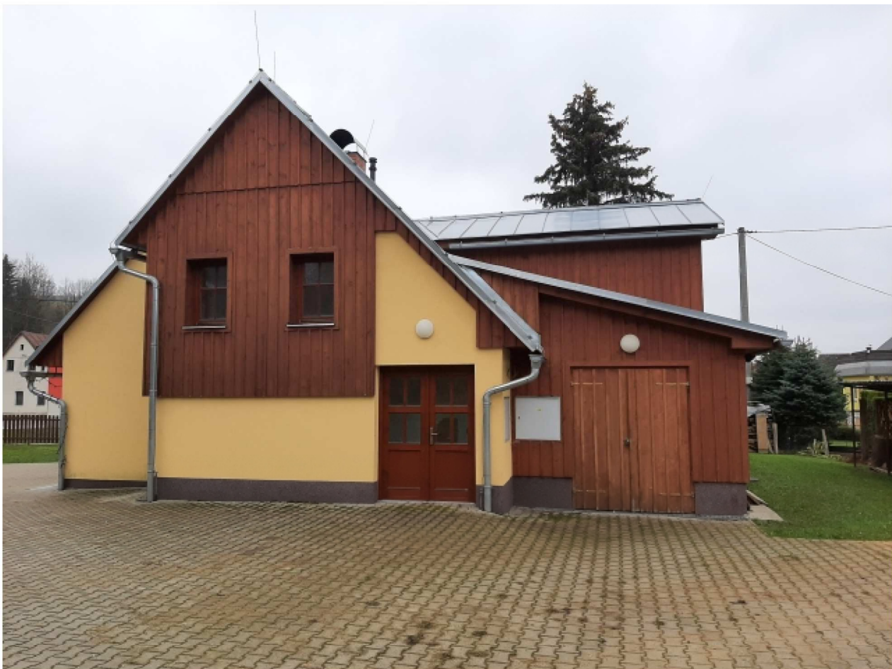
3. Obslužný objekt ČP. 75 - pravá strana
