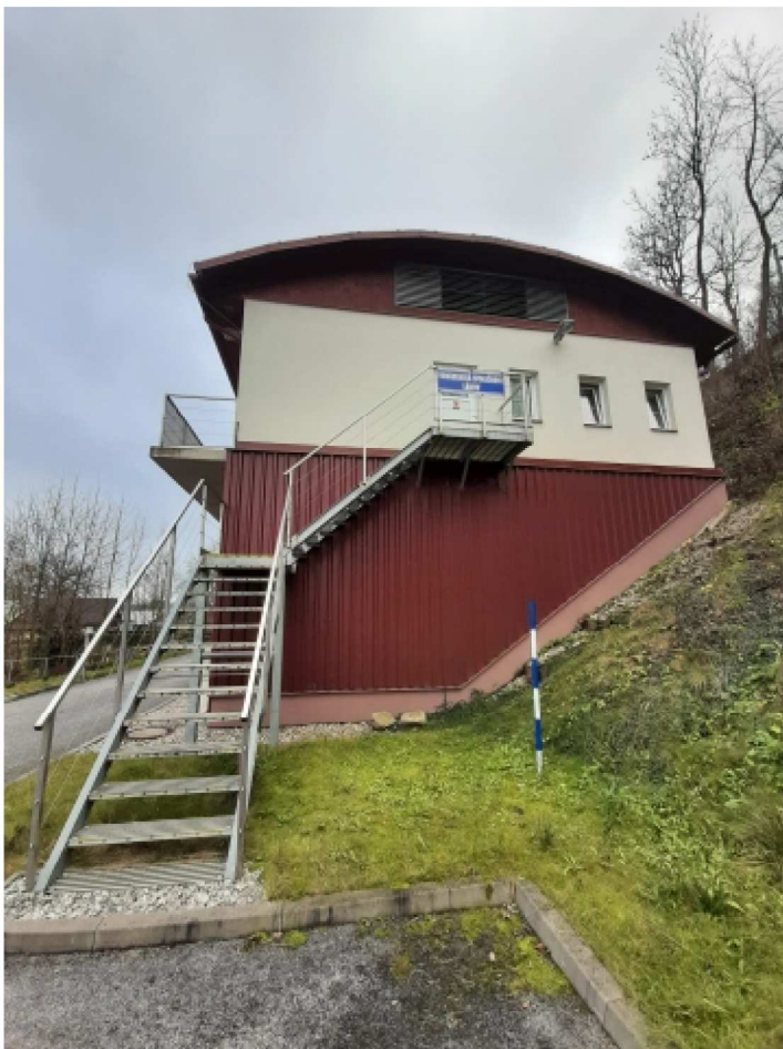
19. Budova ČOV - provozní objekt - přední strana
