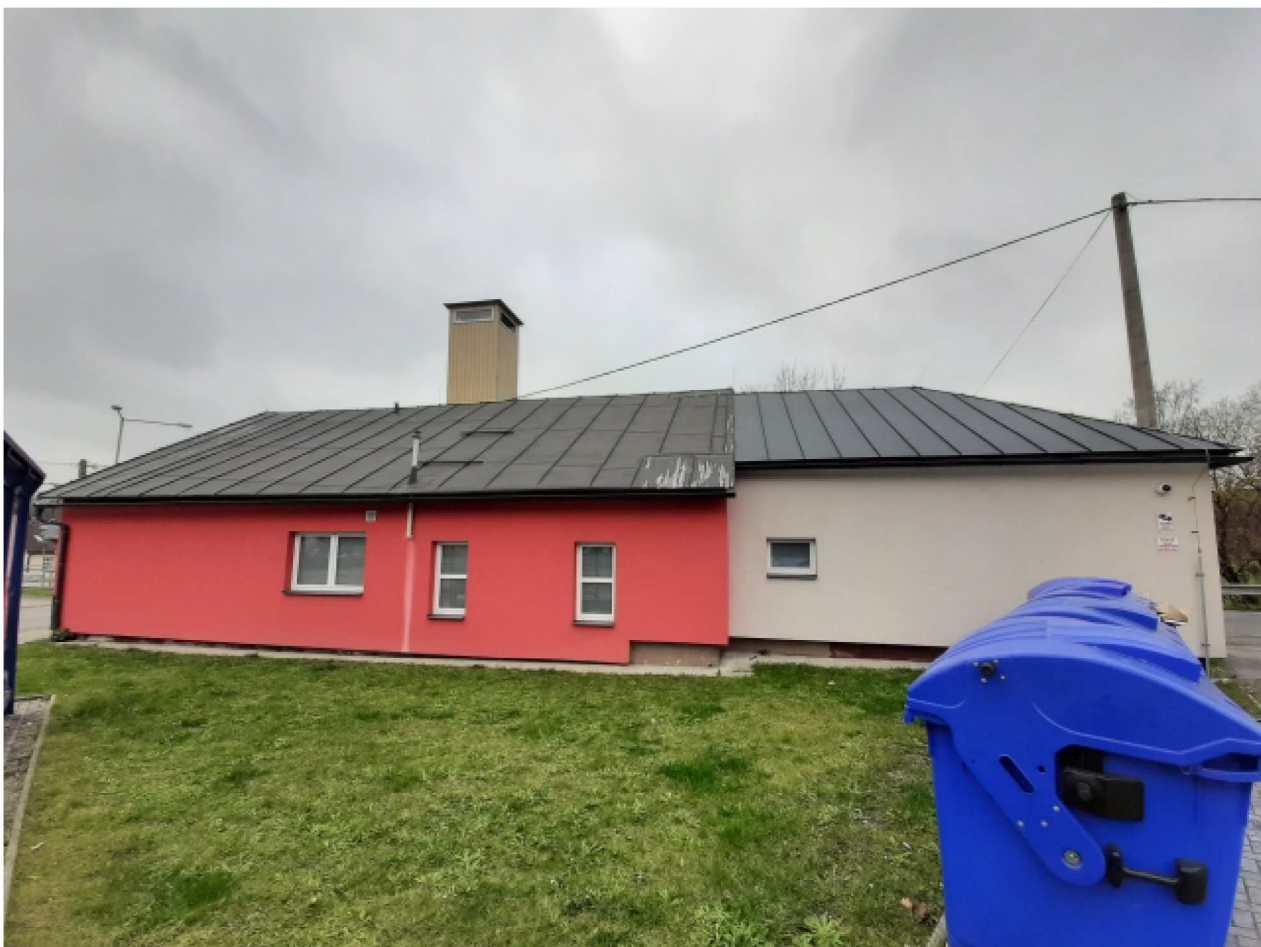
8. Hasičárna PL ČP. 128 - pravá strana
