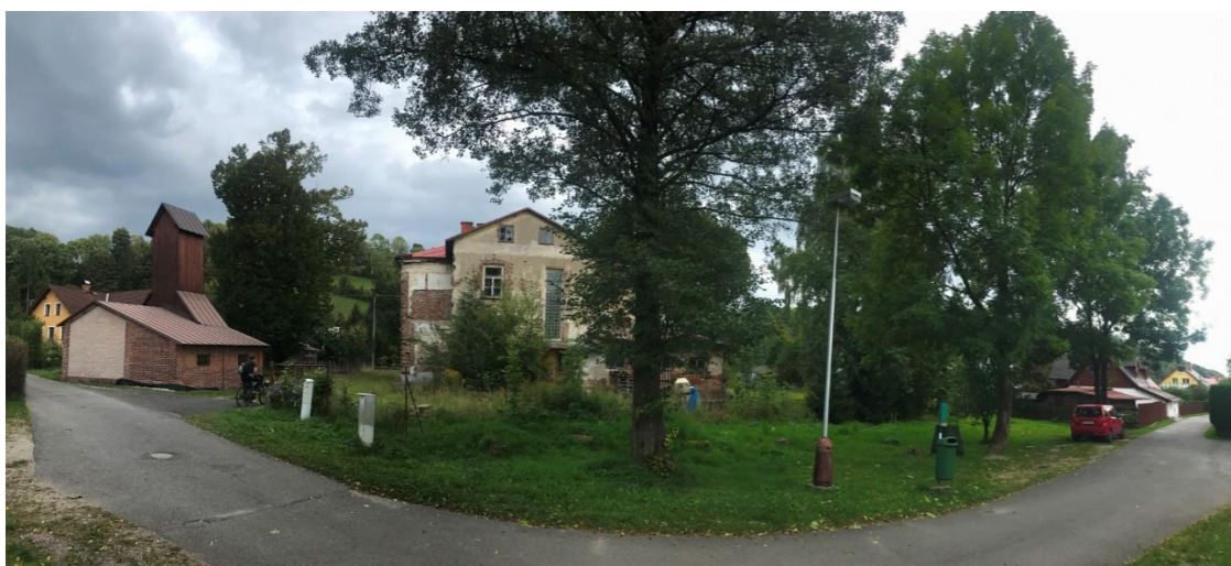
Současný stav při pohledu zezadu na školu
